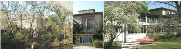
Ansichten des Hermann-Föttinger-Gebäudes
